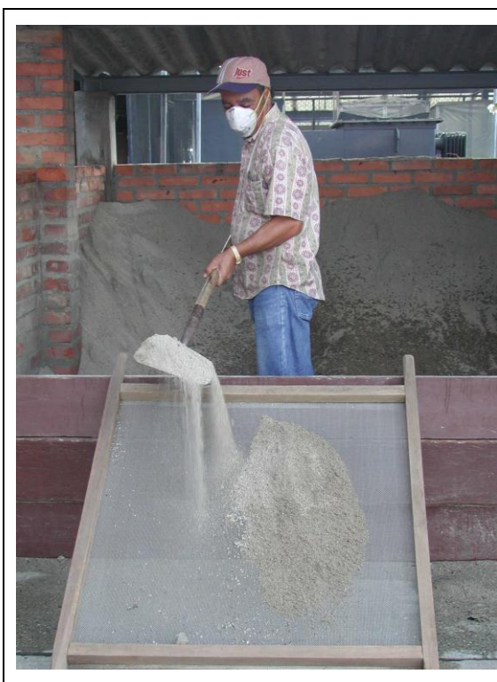
Figura 3-3. Zaranda para tamizar suelo y arena en el proceso de endurecimiento.
