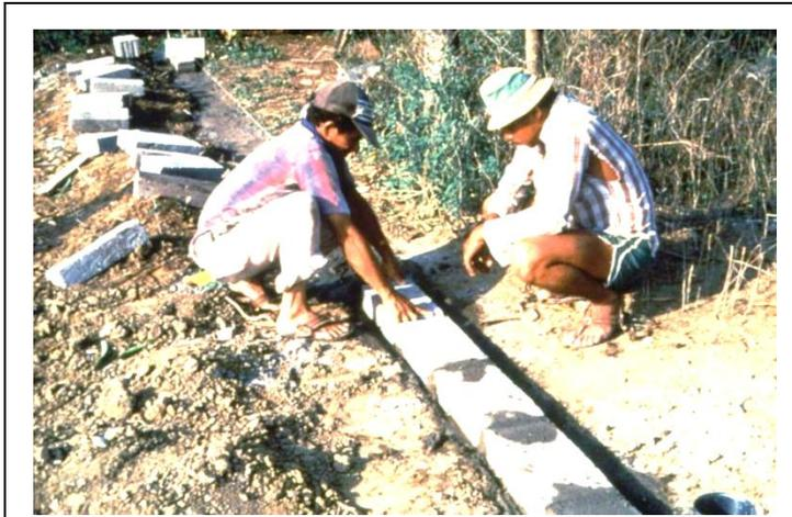
Figura 20. Cimiento que sostiene las paredes externas de la bodega.
